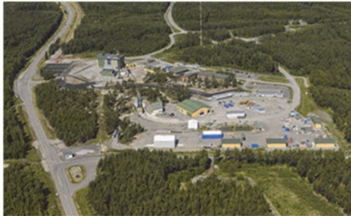
写真Ⅳ.6.1 2014 年の完成後の ONKARO 地上部 ( http://www.posiva.fi/en )(2018 年 2 月から)
