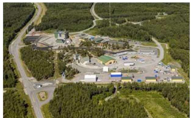
写真 2014年完成後のONKARO地上部 ( http://www.posiva.fi/en )(2018年2月より)
