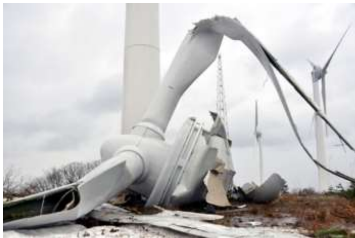
産経新聞 5月9日(木)配信 = 3月14日の強風で落下した京都府の太鼓山風力発電所の風車 = (写真：産経新聞)
