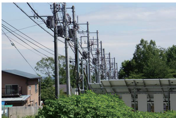
写真1 中規模太陽光発電の送電のために立ち並ぶ電柱と変圧器 （山梨県北杜市清里地区の別荘地の道路にて撮影：経済・環境ジャーナリスト石井孝明氏提供）
